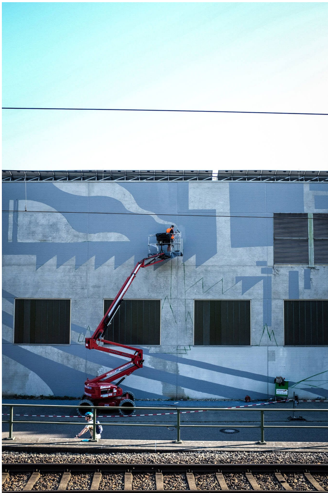
Der Entstehungsprozess des über 1.200 m 2 großen Graffitimotivs auf der Betonfassade des ETTLIN Gewerbeparks in der Pforzheimer Straße in Ettlingen.
