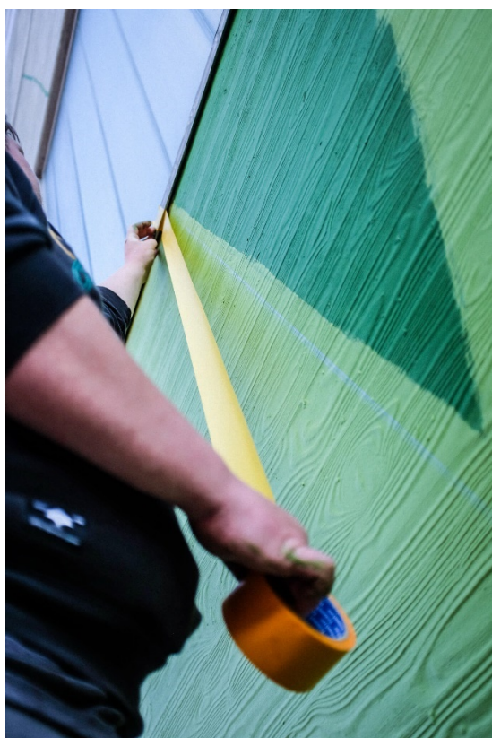
Mindestens 300 m Klebeband waren notwendig, um die unterschiedlichen Elemente des Graffiti-Murals an der ETTLIN Fassade exakt streichen zu können. Im Bild zu sehen: Die Entstehung der Baummotive.
