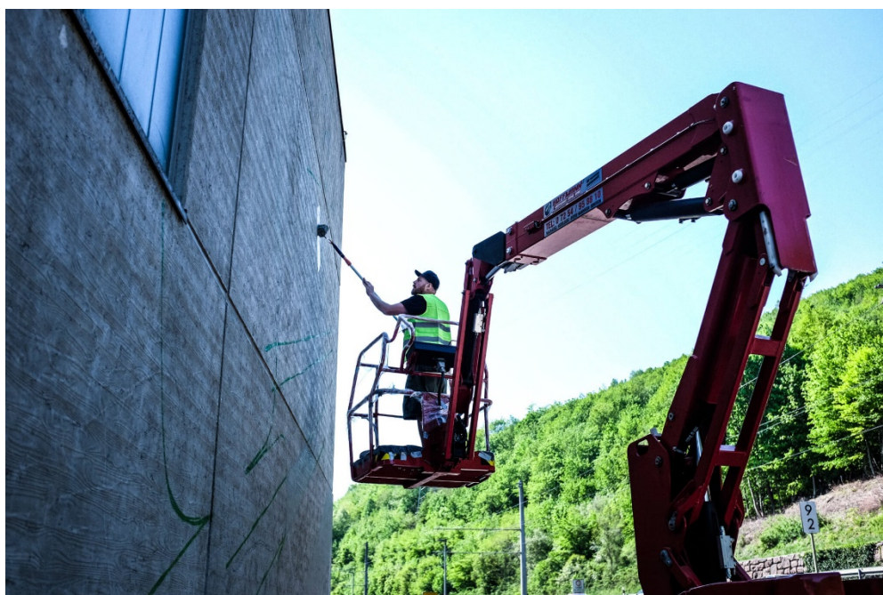
Einer der Graffitikünstler, Rene Sulzer, beim Anstrich der 12 m hohen Fassade vom ETTLIN Gewerbepark.
